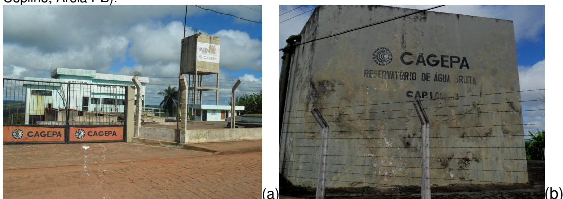
Figura 7 – Estação de Tratamento de Água (a) e reservatório elevado (b) (Distrito de Cepilho, Areia PB).
