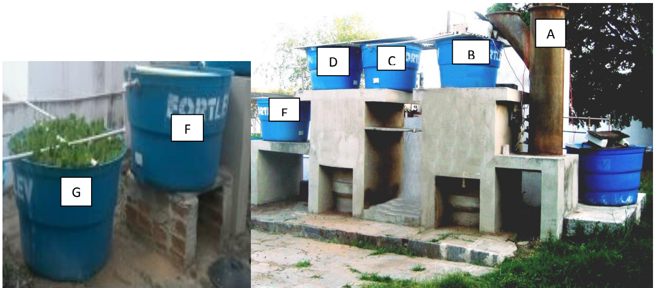
Figura 2 - Sistema de tratamento biológico de esgoto doméstico: (A) reator UASB; (B) tanque de equilíbrio, (C) filtro de areia de fluxo intermitente; (D) e (E) filtros de areia de fluxo intermitente em série, (F e G) lagoas de macrófitas.
