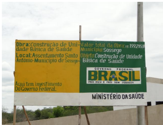
Imagem 6: Placa de obra pública, Assentamento Santo Antônio Fonte: acervo particular da autora
