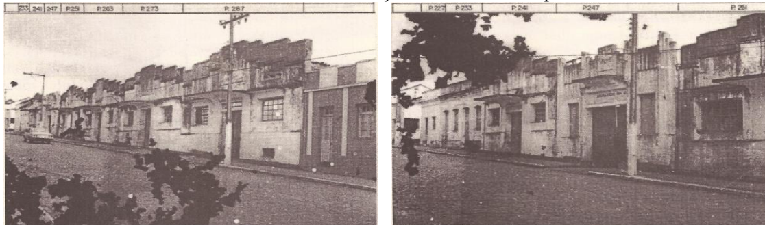
Foto 11: Armazéns, almoxarifado e casa de força da Fábrica Arenópolis S/A
