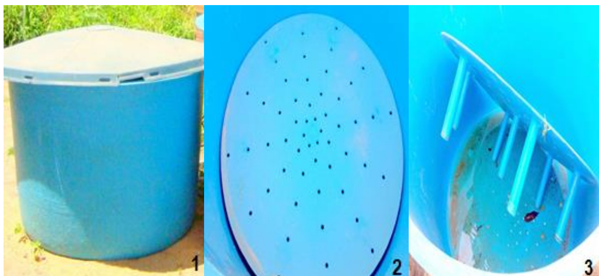
Figura 2 – Detalhamento do filtro anaeróbio submerso.
