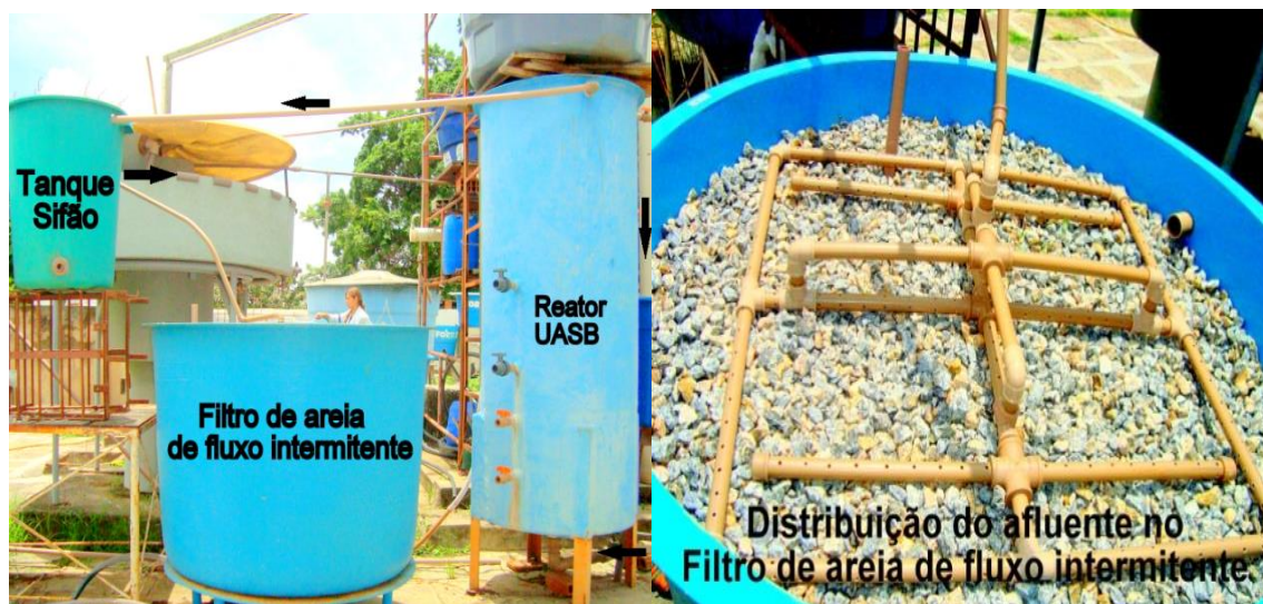
Figura 3 – Detalhamento do filtro de areia de fluxo intermitente.
