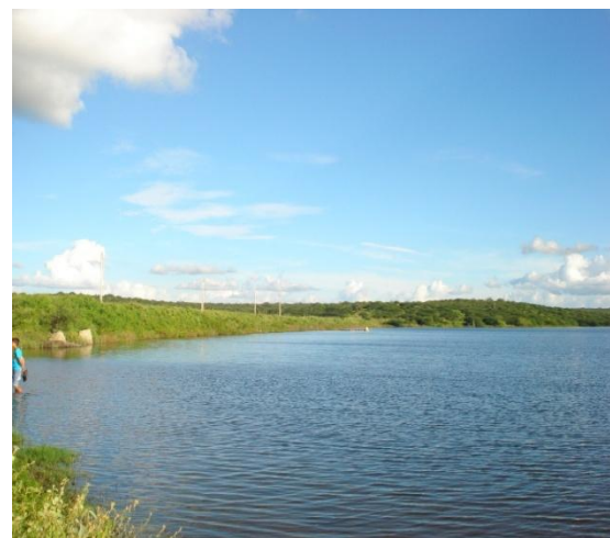
Vista da parede do Açude Santa Rita
