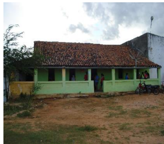
Sede da Associação dos Moradores do PA São Luis
