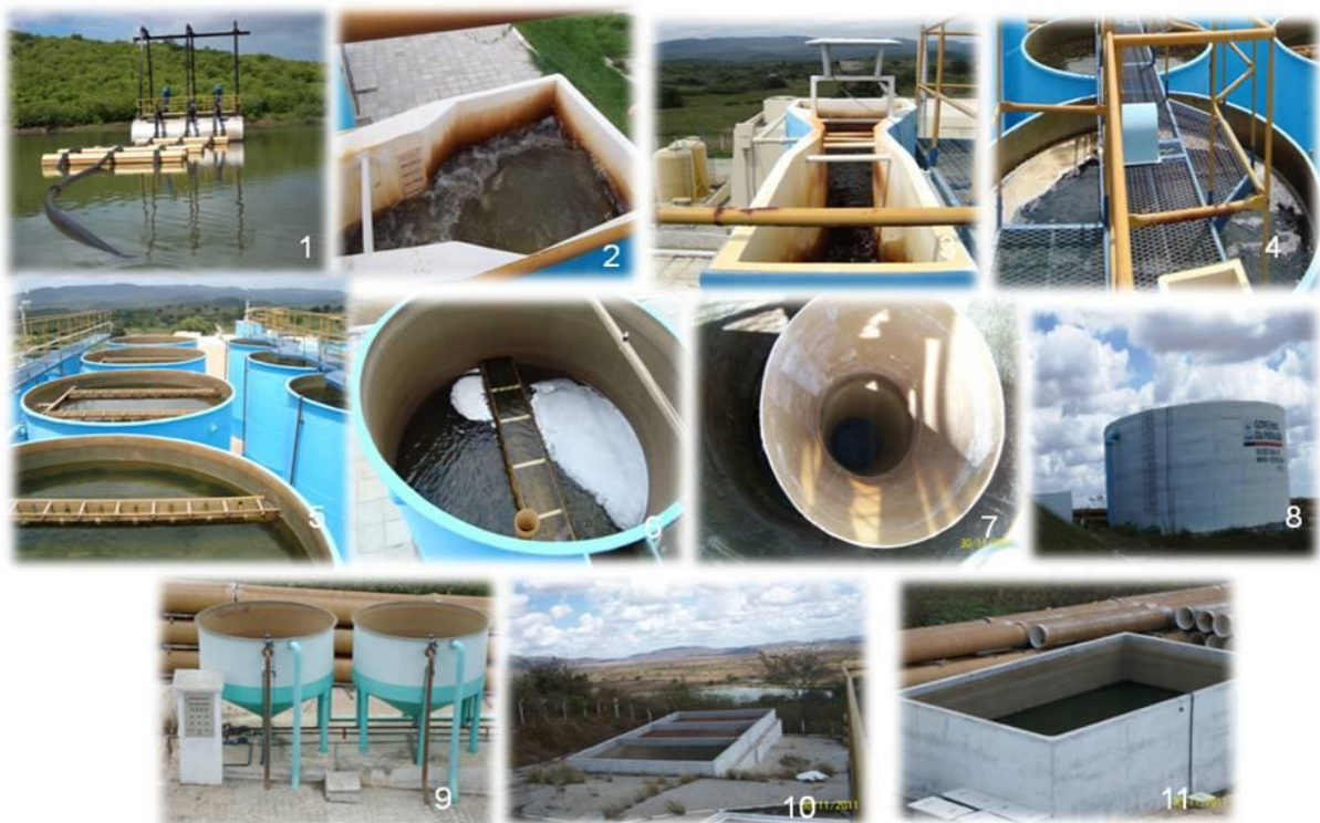
Figura 8. Estação de tratamento de água convencional de Itatuba/PB.
