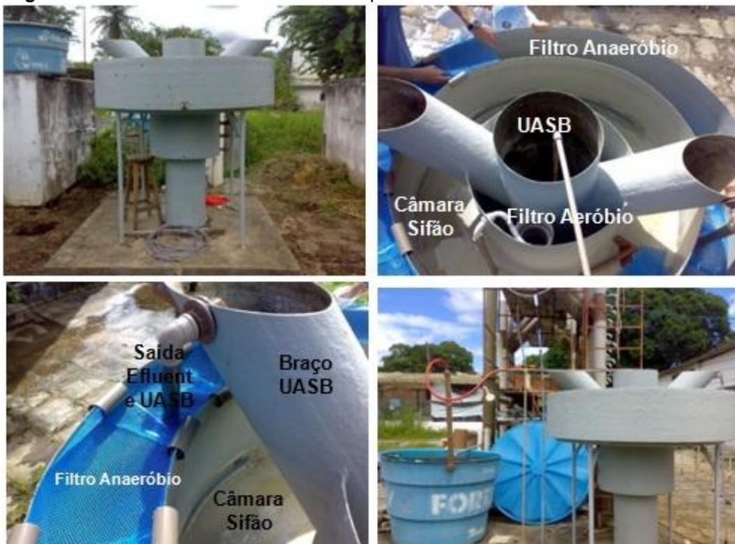
O sistema compacto foi construído de fibra de vidro e constituído por um reator UASB, filtro anaeróbio, tanque de sifonamento e filtro aeróbio. Tinha como finalidade tratar esgoto doméstico unifamiliar, para tanto, foi construído um hidrograma com base em uma família de área periurbana.
