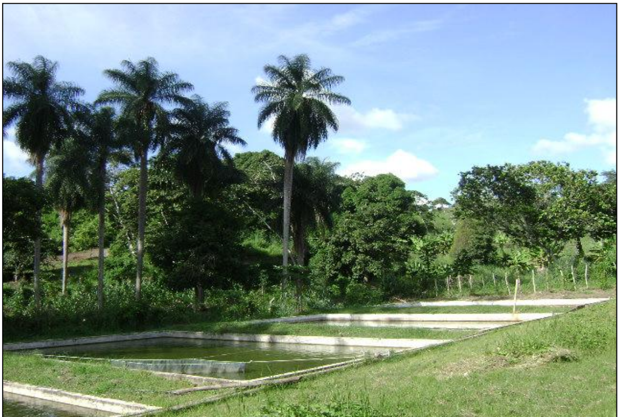
Figura 02: Vista geral dos tanques de alvenaria com fundo de terra com sistema de abastecimento e escoamento individual (módulo de piscicultura – UFPB – Campus II).
