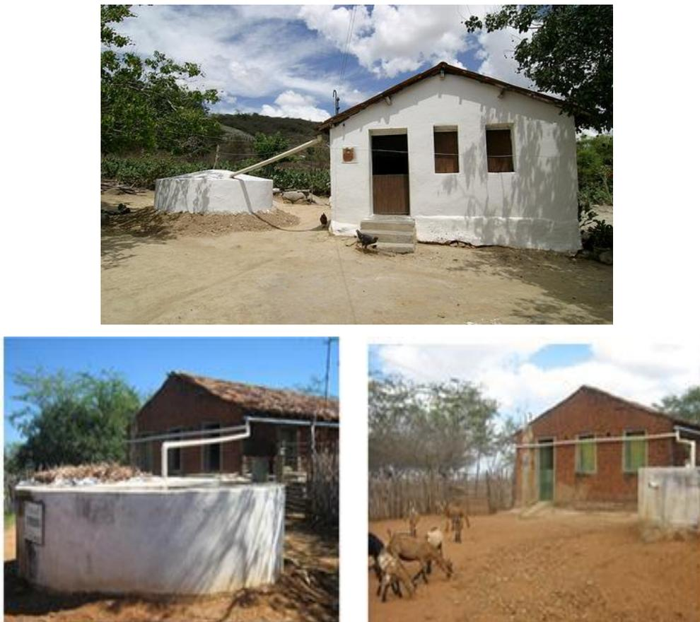
**Figura 03:** Modelos de Cisternas de placas distribuídas pelo PIMC.
