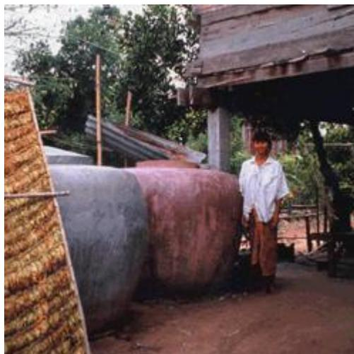
**Figura 02.** Jarras usadas no armazenamento da água da chuva na Tailândia.
